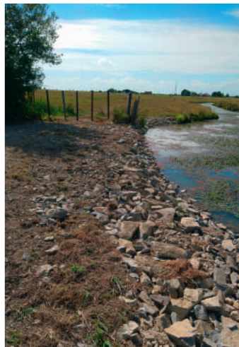
Réfection de berges par enrochement.
