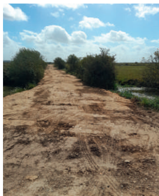
Travaux d'entretien d'un chemin de marais.
