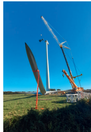
Travaux de réfection de l'éolienne. Changement de la boîte de vitesses.
