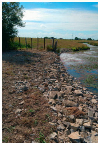
Réfection de berges par enrochement.
