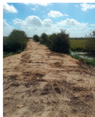
Travaux d'entretien d'un chemin de marais.
